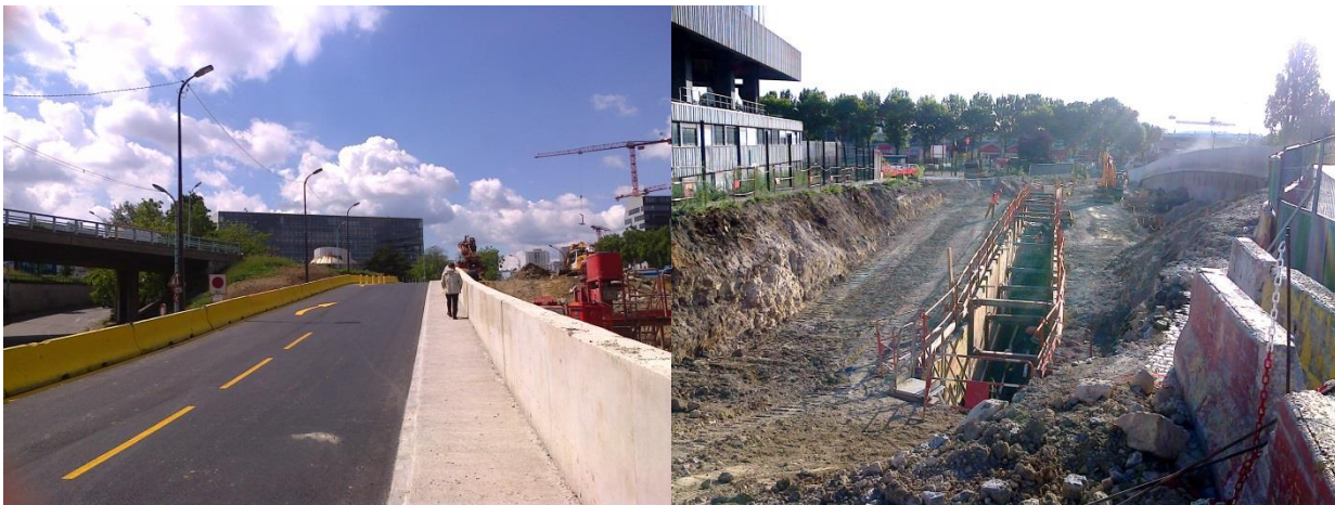
Construction des ouvrages d'assainissement de la future rue J.B.Berlier
